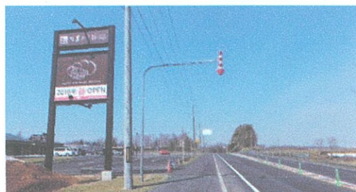
<国道234号 道の駅出入口付近 (苫小牧からの車線)>
